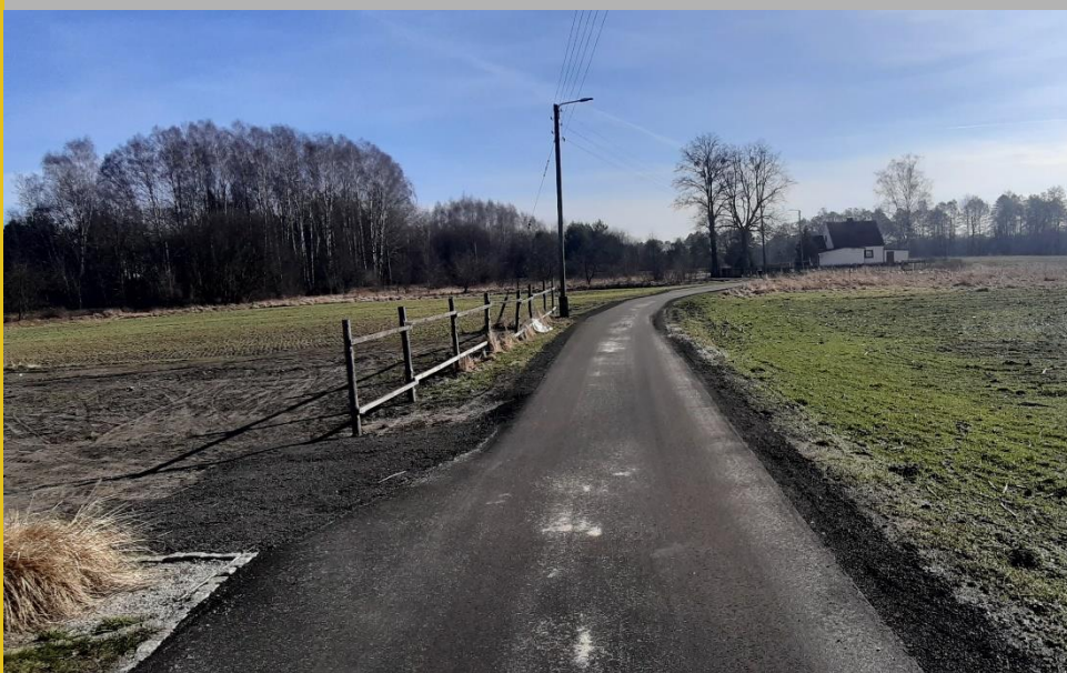
Budowa ul. Polnej w Fosowskim
