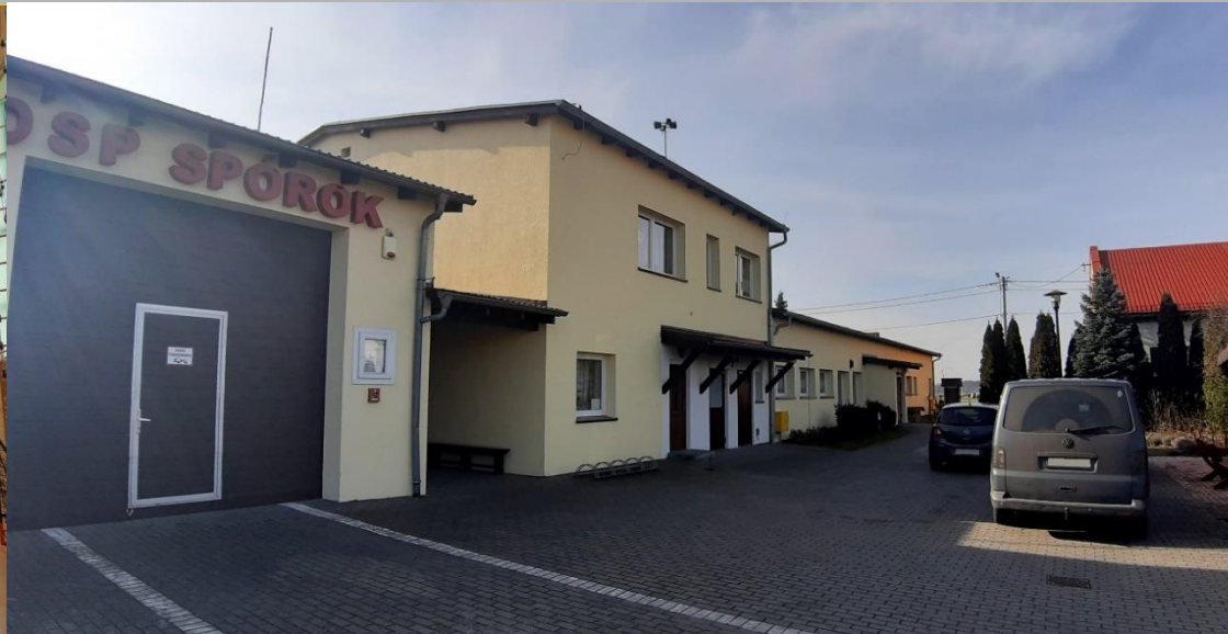
Odnowienie elewacji budynku CAW w Spóroku
