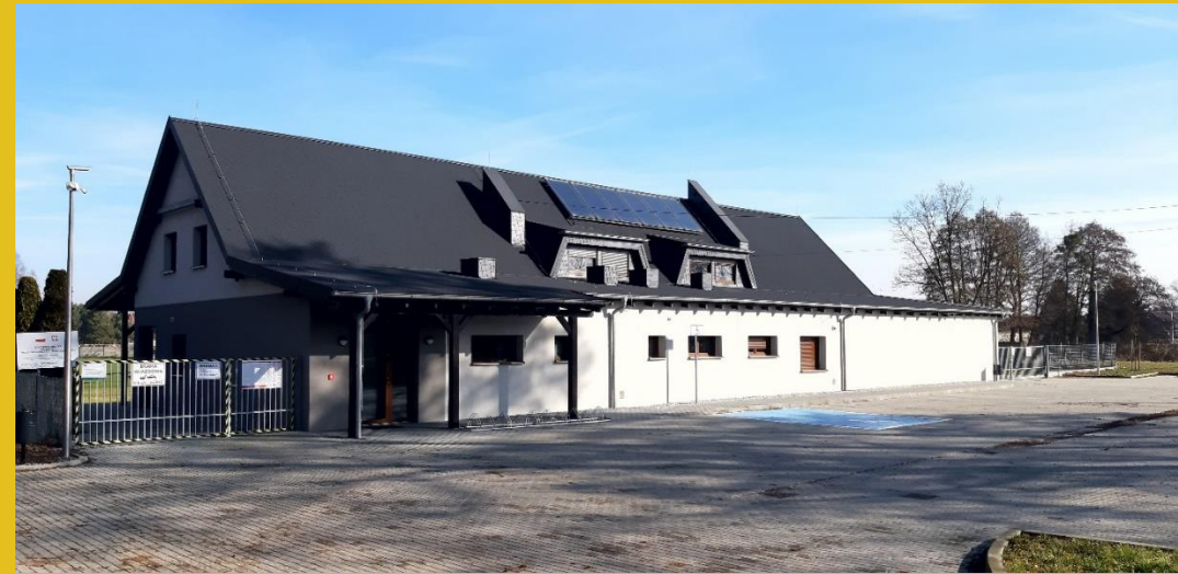
Przebudowa Miejskiego Centrum Sportowo-Kulturalnego
