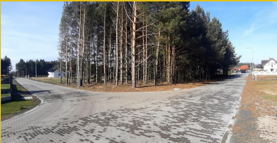
Budowa ulicy Bukowej w Kolonowskim
