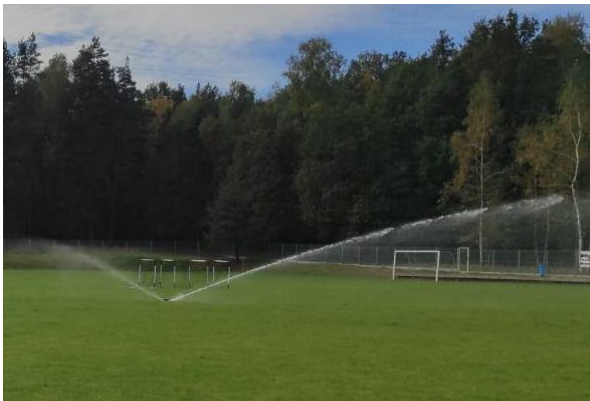
Zdjęcie 10. Budowa nawodnienia na boisko LZS w Staniszcach Wielkich
