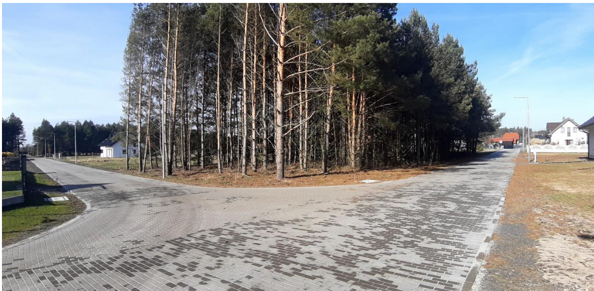
Zdjęcie 6. Budowa ul. Bukowej w Kolonowskiem
