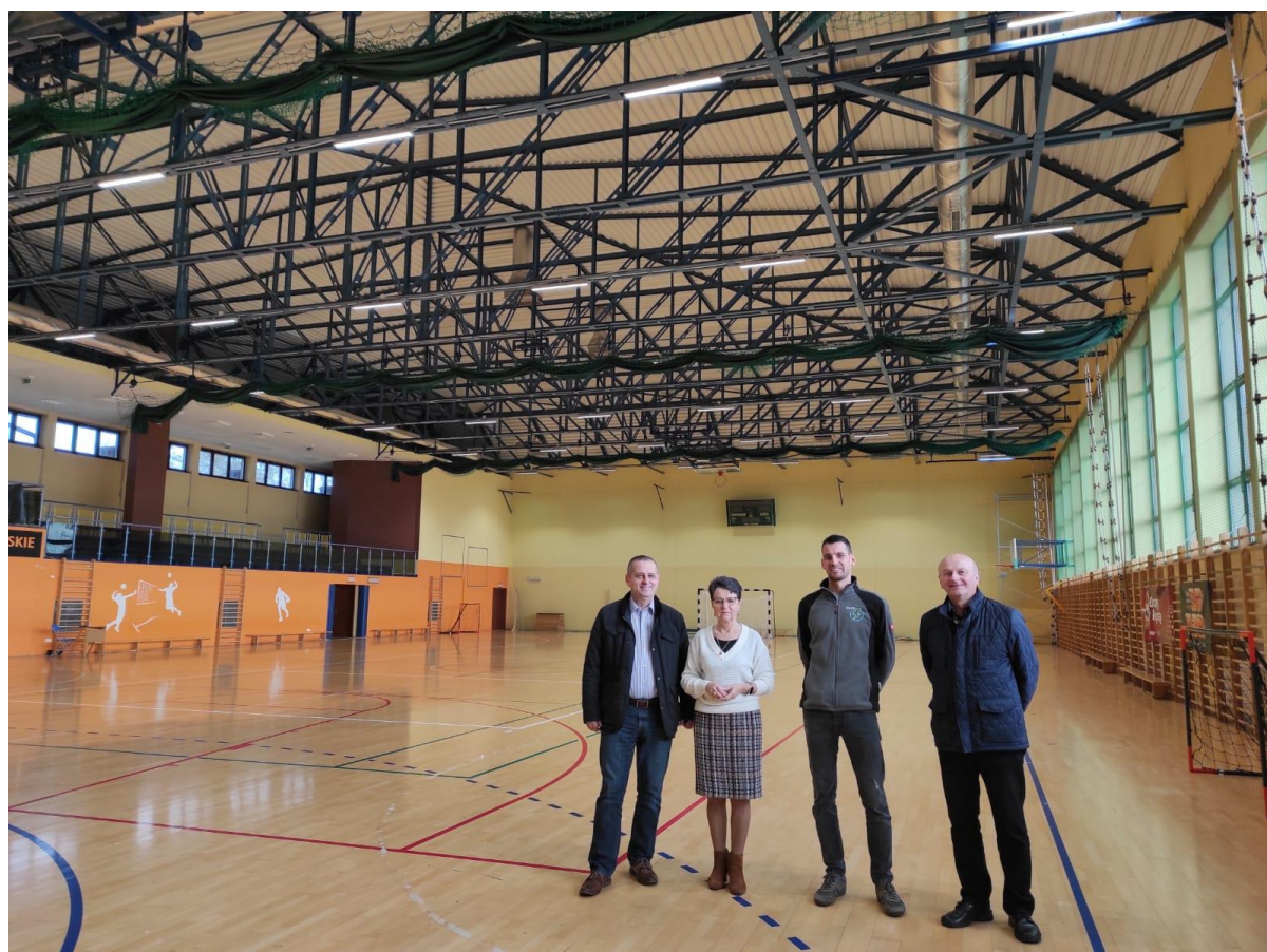
Zdjęcie 11. Modernizacja oświetlenia hali sportowej w Kolonowskiem
