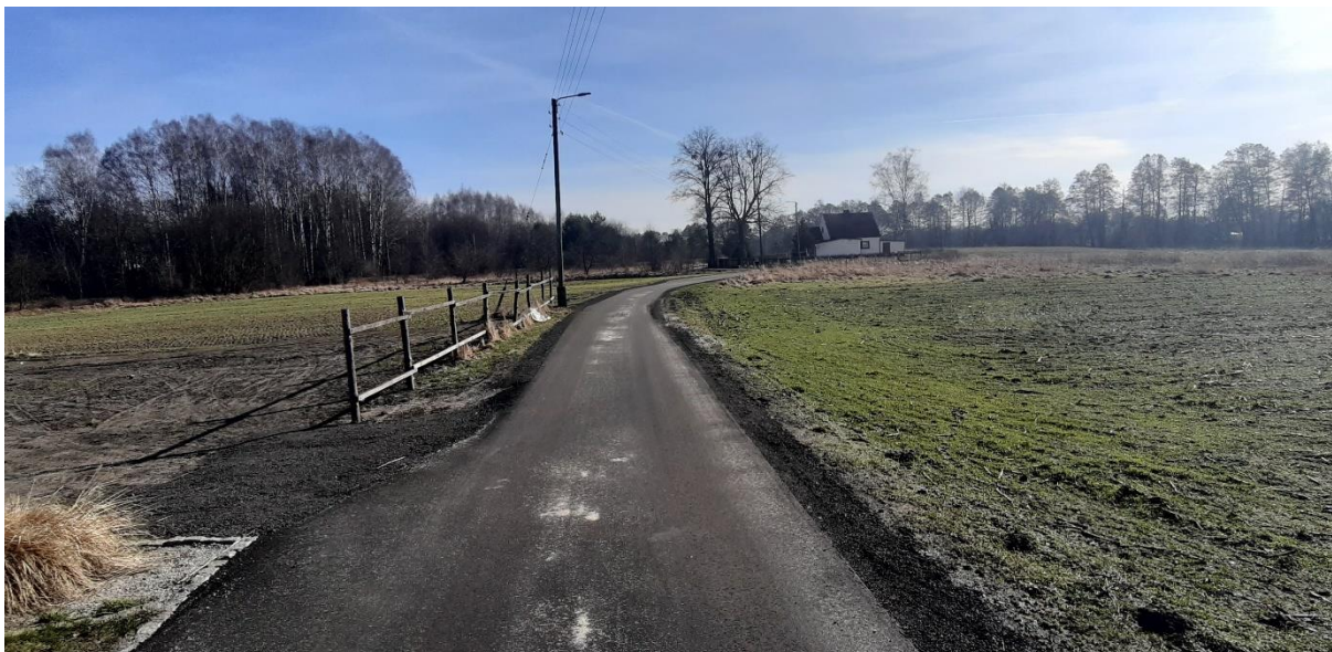
Zdjęcie 8. Budowa ul. Polnej w Kolonowskie (Fosowskie)
