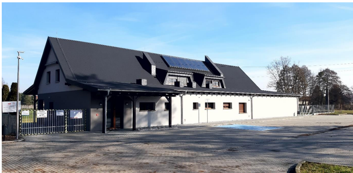
Zdjęcie 9. Przebudowa Miejskiego Centrum Kulturalno-Sportowe w Kolonowskiem
