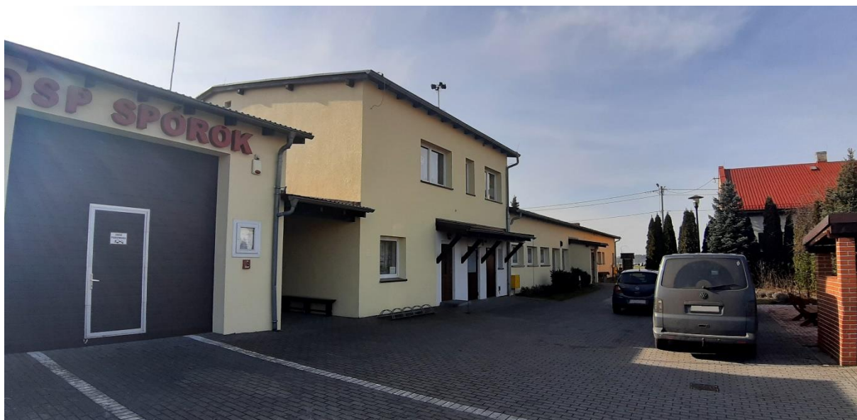
Zdjęcie 12. Odnowienie elewacji budynku CAW w Spóroku.
