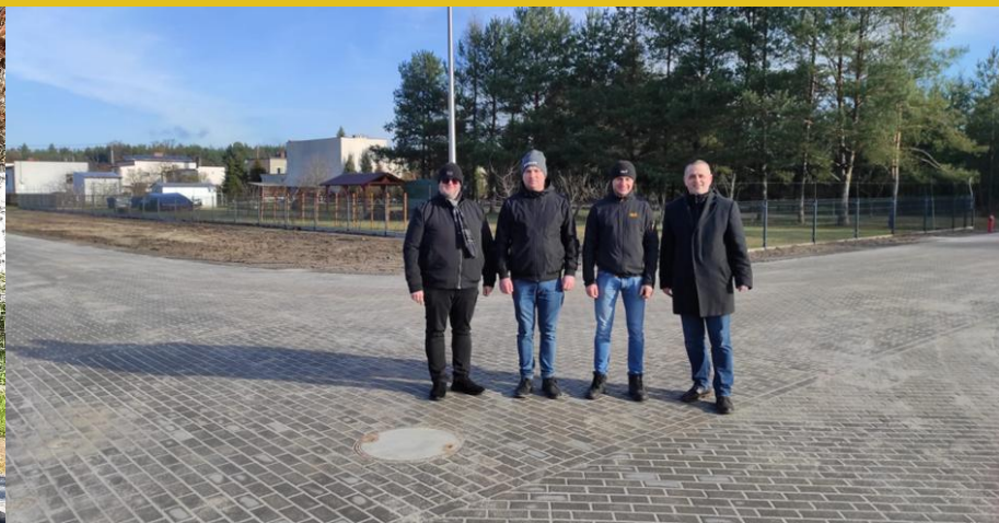
Budowa ulicy Klonowej w Kolonowskiem
