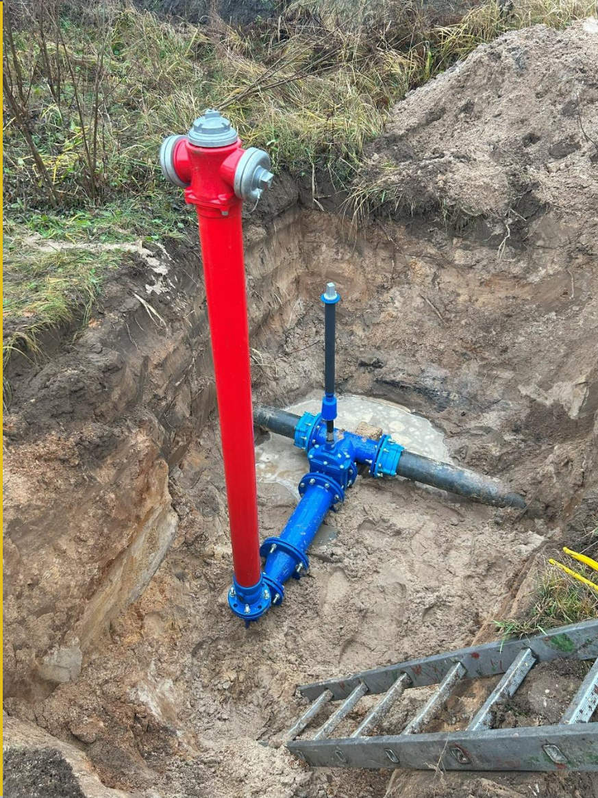
Budowa wodociągów ul. Klonowa
