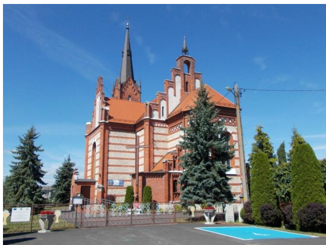
Widok kościoła od strony SW
