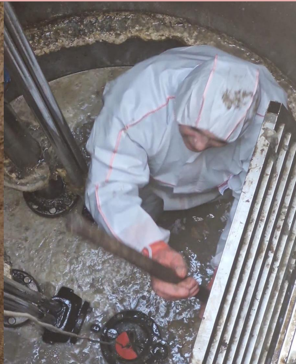
Usuwanie zanieczyszczeń w przepompowniach
