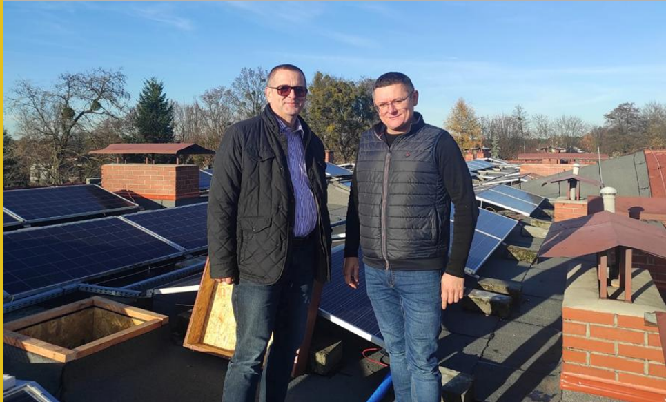
Modernizacja dachu PSP Kolonowskie
