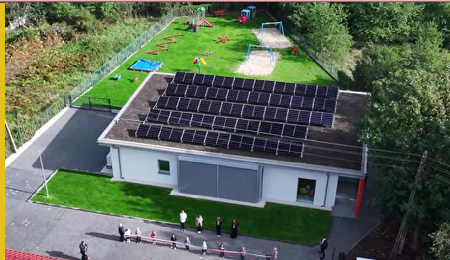
Budowa oddziału przedszkolnego w Fosowskim
