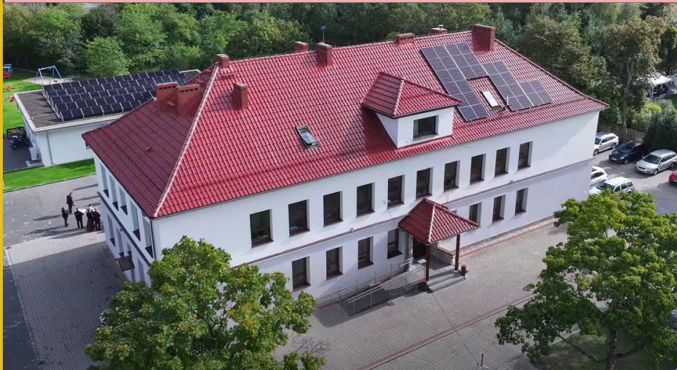
Przebudowa PSP Fosowskie
