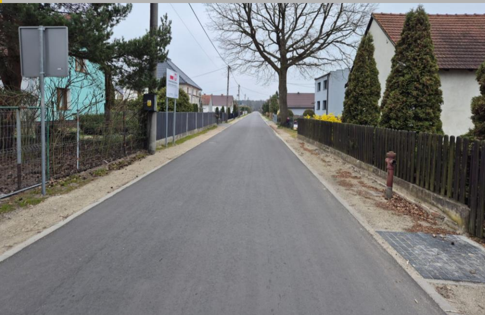
Budowa ulicy Guznera w Spóroku
