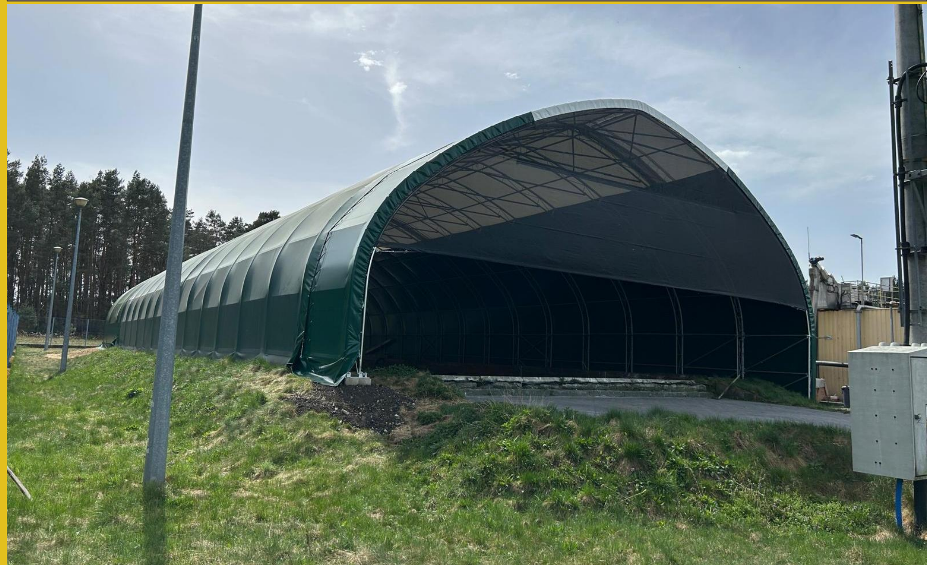
Rozbudowa tunelu foliowego na oczyszczalni ścieków
